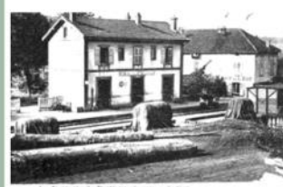
Le «RAMBER», ligne de chemine de fer de Charmes à Rambervillers
